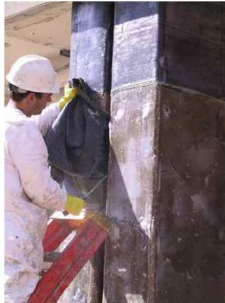
(b) CFRP 기둥보강
